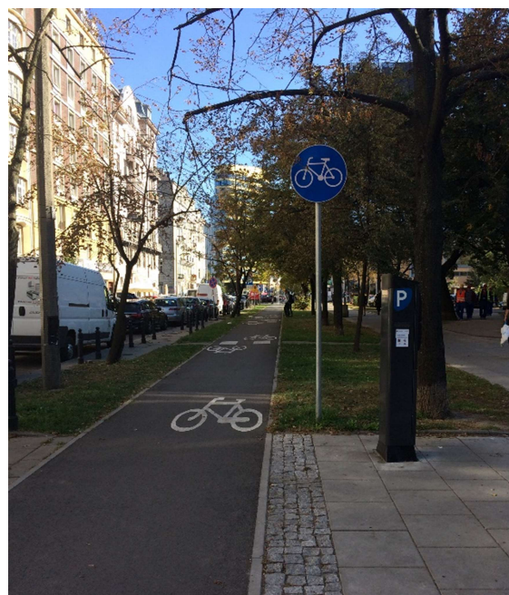
Wydzielona droga dla rowerów – oddzielona od chodnika pasem zieleni, w miejscu przylegającym do chodnika, buforem z kostki
