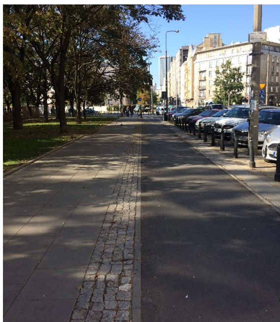
Wydzielona droga dla pieszych i rowerów z podziałem na przestrzeń dla pieszych i rowerzystów, oddzielone od siebie buforem (pas z kostki)
