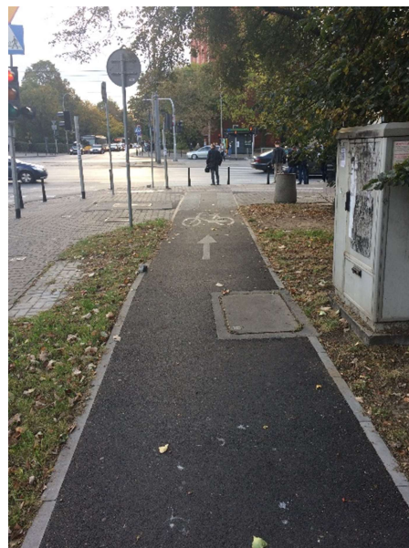
Wyprowadzenie ruchu rowerowego z pasa rowerowego i połączenie z drogą dla rowerów przebiegającą równolegle do jezdni – przykład odcinka jednokierunkowej drogi dla rowerów.
