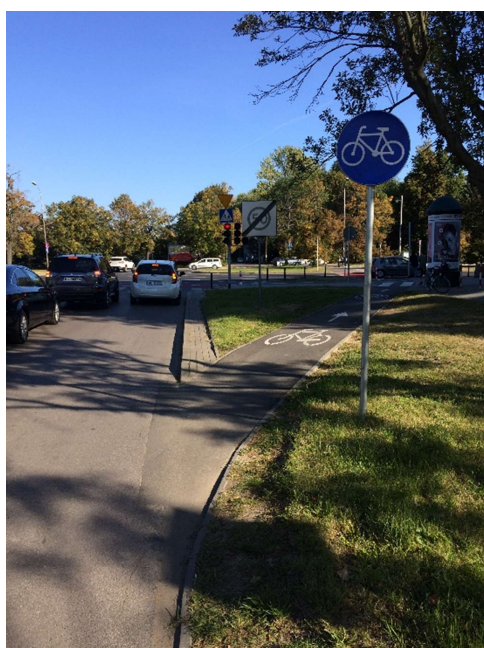
Wyprowadzenie ruchu rowerowego z jezdni o ruchu uspokojonym (30 km/h) na drogę dla rowerów poprzez odcinek jednokierunkowej drogi rowerowej.
