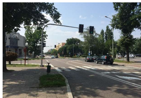
Fot. 2.10. Skrzyżowanie 3 Maja/Batorego – stan istniejący.
