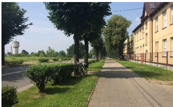
Fot. 2.8. Ul. 3 Maja, odcinek Sportowa – rondo św. JPiI – rejon ronda św. JPiI – widoczna strona wschodnia, gdzie zakłada się wprowadzenie drogi dla pieszych i rowerów (C13/C16).
