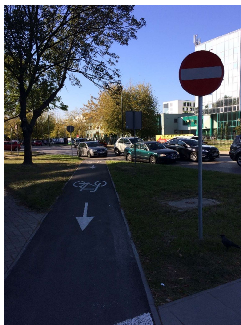
Wyprowadzenie ruchu rowerowego z jezdni o ruchu uspokojonym (30 km/h) na drogę dla rowerów poprzez odcinek jednokierunkowej drogi rowerowej.
