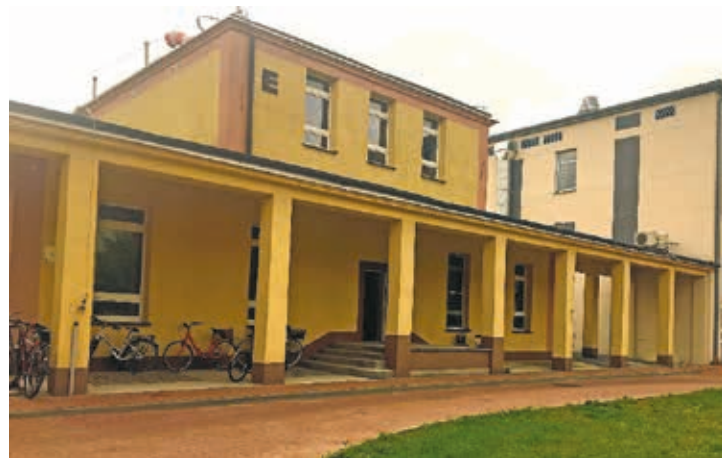
Budynek kuchni szpitalnej – stan obecny
