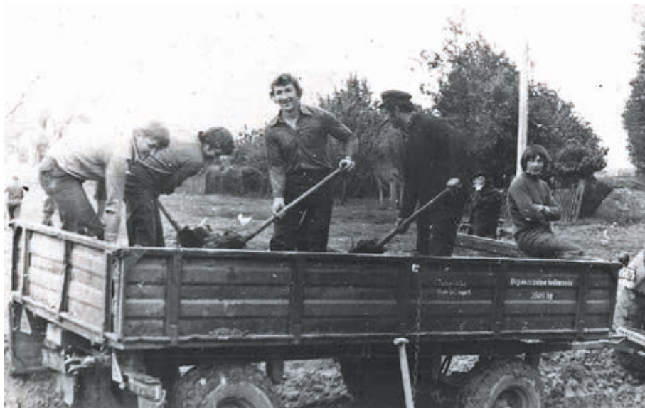
Mieszkańcy Starego Berezowa podczas budowy świetlicy.
