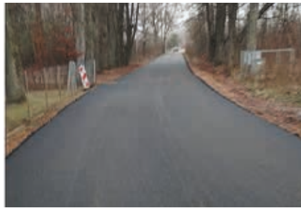
Przebudowa drogi gminnej w Soroczej Nózce
