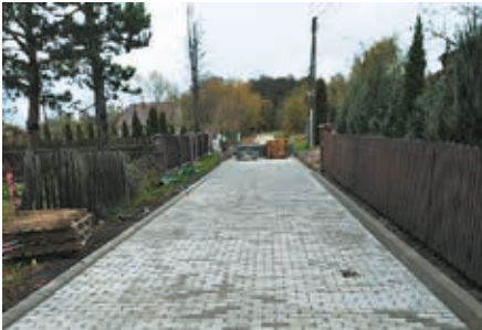
Przebudowa ul. Łąkowej w Dubinach
