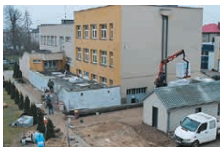
Prace budowlane przy przebudowie kotłowni CKP
