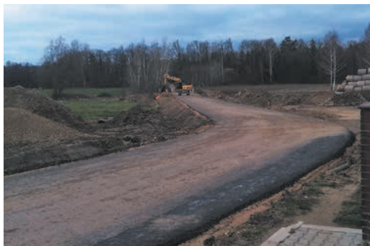
Końcowe prace przy przebudowie drogi w miejscowości Niewino Popławskie
