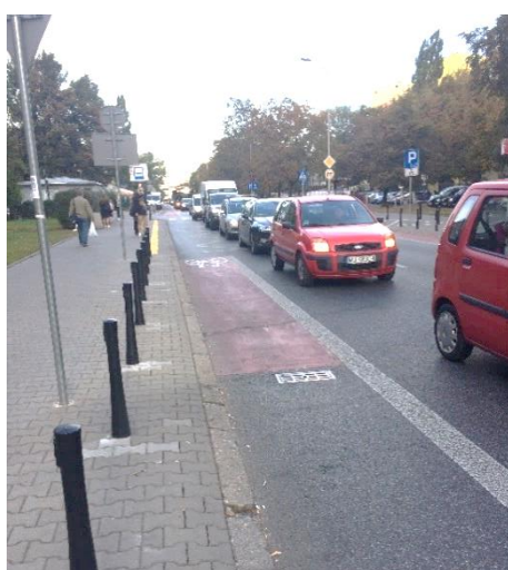
Pas ruchu dla rowerów, punktowo o czerwonej nawierzchni z zakazem parkowania (zastosowanie słupków zabezpieczających przed parkowaniem niezgodnym z przepisami)
