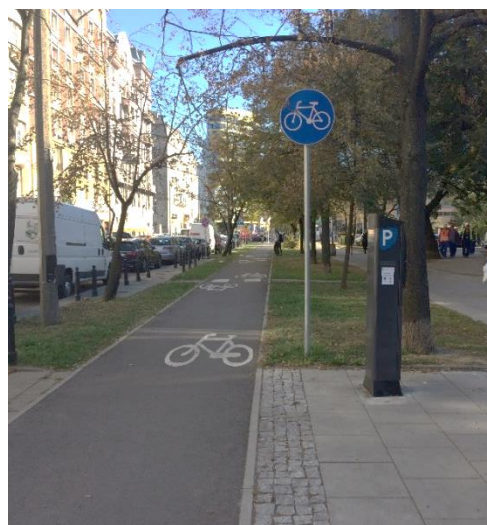
Przykład wydzielonej drogi dla rowerów, oddzielonej od chodnika pasem zieleni a w miejscu przylegającym do chodnika buforem z kostki
