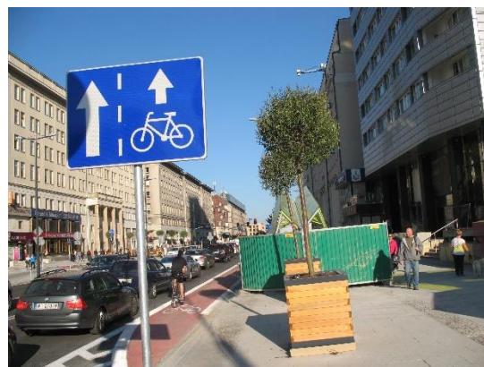
Przykład wprowadzenia ruchu rowerowego na jezdnię – pas ruchu dla rowerów (znak pionowy F-19)
