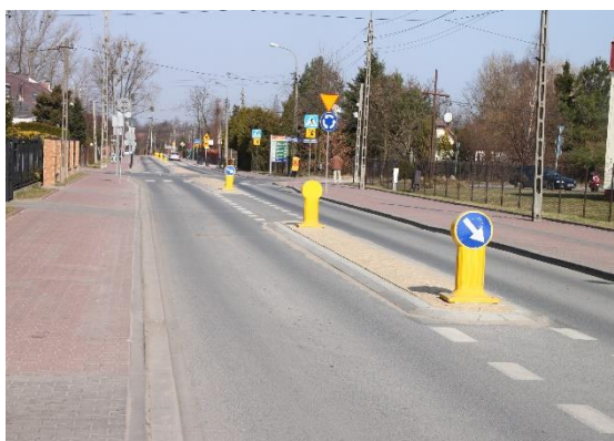
Przykład uspokojenia ruchu na ulicy z zastosowaniem wąskich, przerywanych pasów dzielących umożliwiających zjazdy do posesji – ruch rowerowy po jezdni
