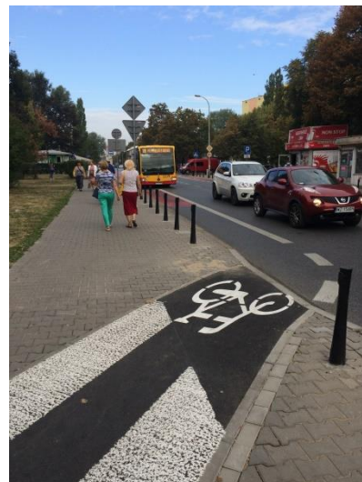
Wyprowadzenie ruchu rowerowego z pasa ruchu dla rowerów na drogę dla rowerów przebiegającą równoległą do jezdni – przykład odcinka jednokierunkowej drogi dla rowerów
