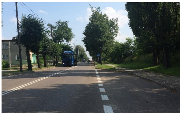
Fot. 7.7. Ul. 3 Maja, odcinek Sportowa – rondo św. JPiI – rejon zatoki autobusowej po południowej stronie skrzyżowania 3 Maja/Sportowa – widoczna strona zachodnia, gdzie zakłada się: drogę dla pieszych i rowerów (C13IC16) do przejścia dla pieszych po południowej stronie widocznej na zdjęciu zatoki oraz drogę dla rowerów (C13) na odcinku na południe od ww. przejścia dla pieszych.
