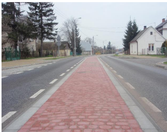
Przykład uspokojenia ruchu na DW 824 w Puławach (wylot na Kazimierz Dolny i Nałęczów) – przejezdny pas dzielący zwężający szerokość jezdni i utrudniający wyprzedzanie
