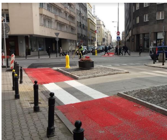
Przykład wyznaczenia kontrapasa rowerowego w obrębie skrzyżowania i przejść dla pieszych z azylem
