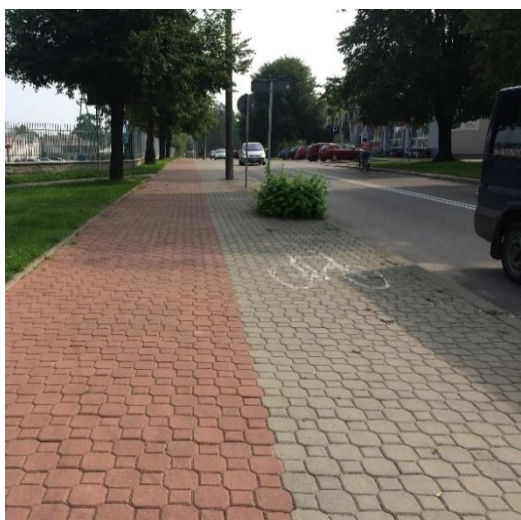
Rys. 3.11 Ul. Armii Krajowej, brak zachowanej skrajni
