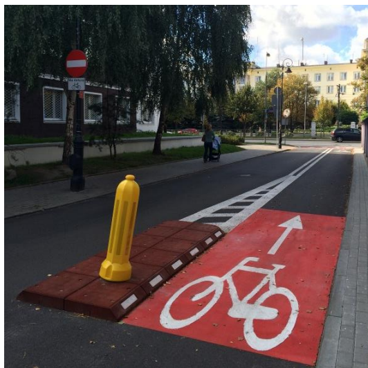
Przykład wyznaczenia kontrapasa rowerowego z zabezpieczeń w postaci wyspy w krawężnikach
