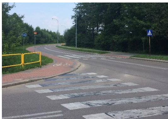
Rys. 3.15 Skrzyżowanie Rakowieckiego/ Żabia Górka. Nieczytelne i niefunkcjonalne rozwiązanie ruchu pieszego i rowerowego.
