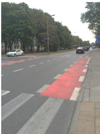
Pas ruchu dla rowerów z przerwaniem ciągłości oznaczenia w obrębie przejścia dla pieszych – oznakowanie przejścia przez wszystkie pasy, ruchu samochodowego i rowerowego
