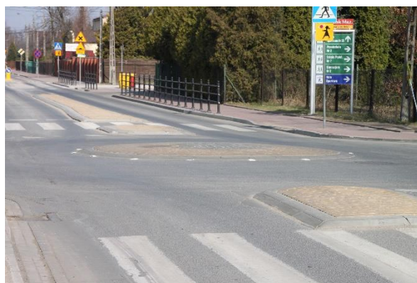
Przykład uspokojenia ruchu w rejonie szkoły, z zastosowaniem skrzyżowania w formie mini ronda - ruch rowerowy po jezdni
