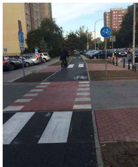
Rys. 7.13. Przykład rekomendowanych przejazdów rowerowych bez sygnalizacji świetlnej w ciągu drogi rowerowej
