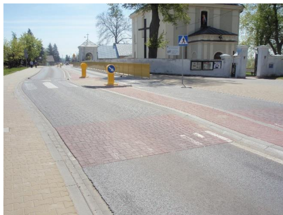
Przykład uspokojenia ruchu na DW 824 w Puławach (wylot na Kazimierz Dolny i Nałęczów) – przejezdny pas dzielący zwężający szerokość jezdni i utrudniający wyprzedzanie, progi zwalniające i przejście dla pieszych z azylem
