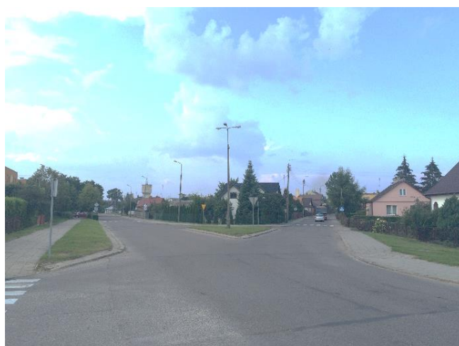
Fot. 7.12. Skrzyżowanie ulic Warszawskiej i Nowowarszawskiej – stan istniejący.
