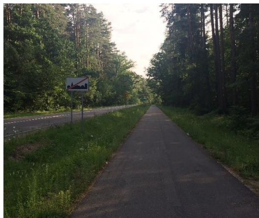
Rys. 3.8 DW 685 w stronę Kleszczel. Początek drogi dla rowerów wykonanej z masy bitumicznej.
