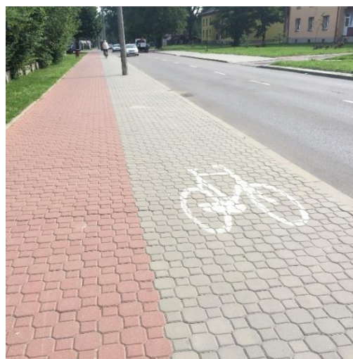
Rys. 3.12 ul. Armii Krajowej, widok oznakowania poziomego – słupy w skrajni ruchu.
