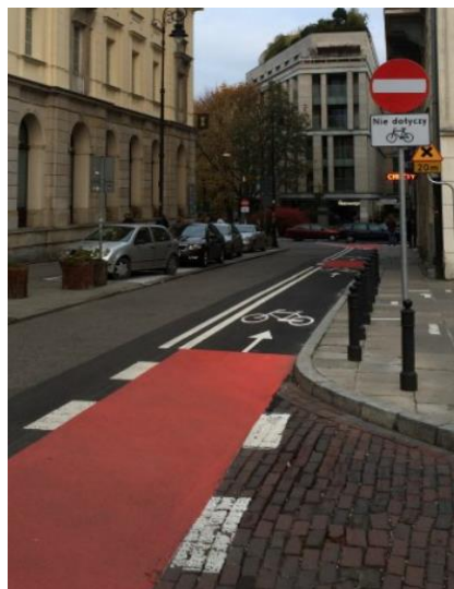
Przykład wyznaczenia kontrapasa rowerowego z ograniczeniem parkowania po stronie ruchu rowerowego
