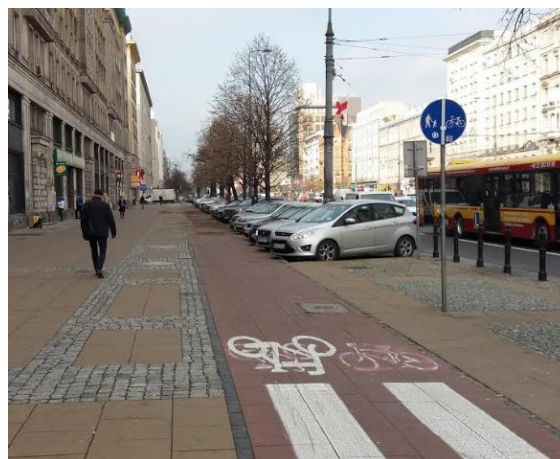
Przykład drogi dla pieszych i rowerów z podziałem na przestrzeń pieszą i rowerową ale bez bufora (rozwiązanie mniej korzystne). Odrębność przestrzeni podkreślona wyłącznie innymi rodzajami nawierzchni
