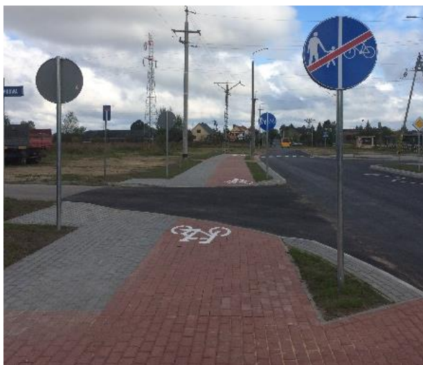
Rys. 7.12. Nowo powstała droga dla pieszych i rowerów wzdłuż ul. Targowej – rekomendowane uzupełnienie o przejazdy rowerowe i likwidacja znaków pionowych – koniec pieszo-rowerowej.
