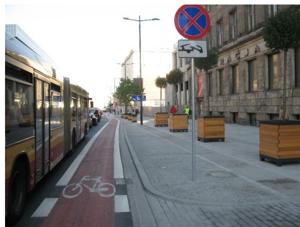
Przykład pasa ruchu dla rowerów z zakazem – zachowana szeroka przestrzeń dla pieszych na chodniku
