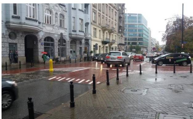
Wyniesiona tarcza skrzyżowania wykonana z innego rodzaju nawierzchni (pod względem kolorystycznym i materiałowym) – zalecane ze względu na dobrą widoczność
