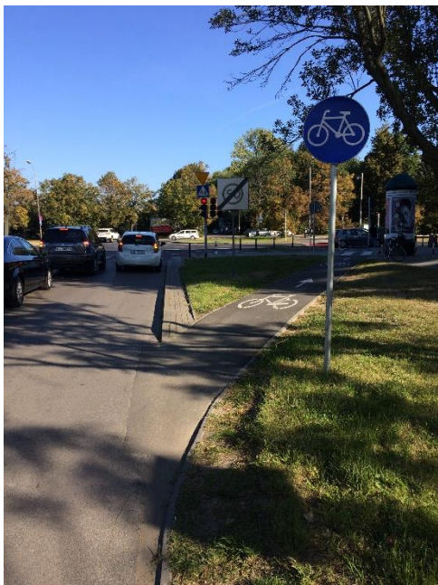
Wyprowadzenie ruchu rowerowego z jezdni o ruchu uspokojonym (30 km/h) na drogę dla rowerów poprzez łącznik jednokierunkowej drogi rowerowej
