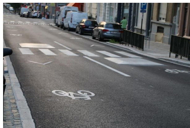
Przykład rozwiązania z zastosowaniem tzw. sierżantów rowerowych i progów zwalniających – informujących kierujących samochodami o konieczności odsunięcia się od prawej krawędzi jezdni i wyznaczającego tor ruchu rowerzystom
