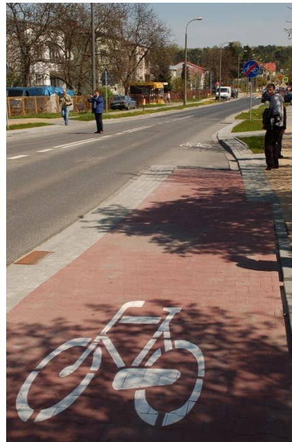
Przykład sposobu rozwiązania wprowadzenia ruchu rowerowego na jezdnię ulicy o ruchu uspokojonym (30 km/h)
