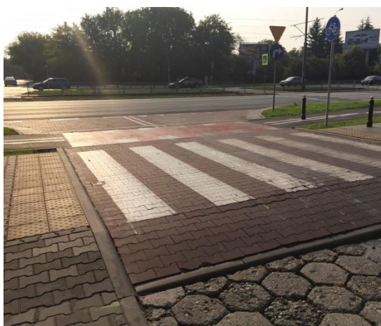
Wyniesienie przejścia dla pieszych i przejazdu rowerowego do poziomu chodnika i drogi dla rowerów będące jednocześnie progami zwalniającym
