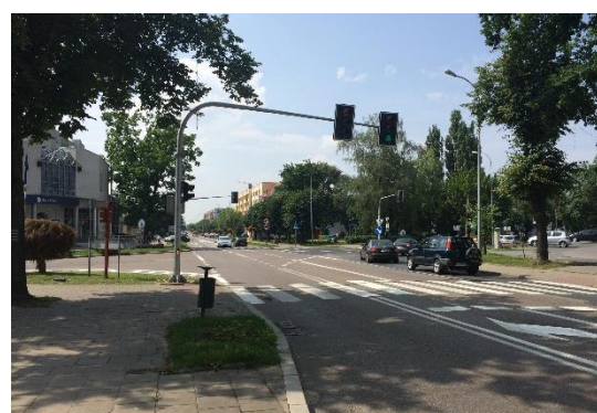
Fot. 7.10. Skrzyżowanie 3 Maja/Batorego – stan istniejący.
